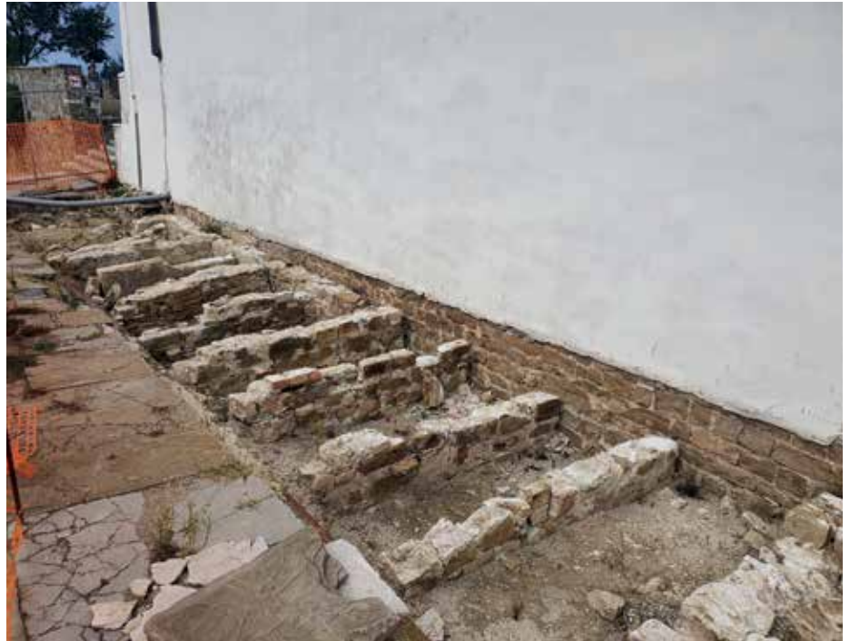
Sanacija poteka na področju, kjer so arheologi odkrili grobnice z grobovi iz poznega srednjega veka.
