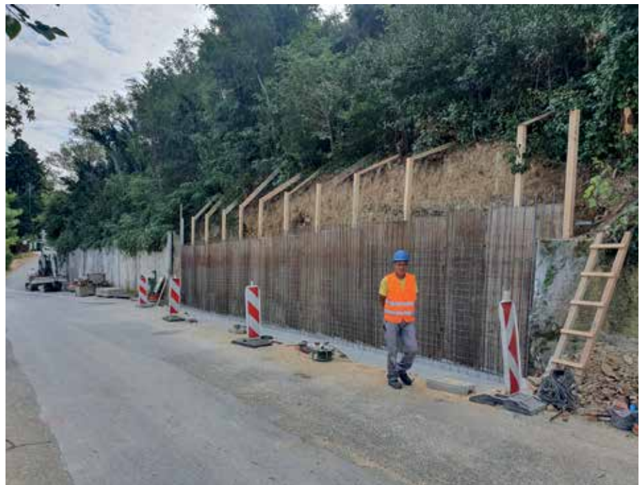
Dela vključujejo preplastitev lokalne ceste v dolžini 998 metrov, ki ni bila v preteklosti nikoli dokončana.
